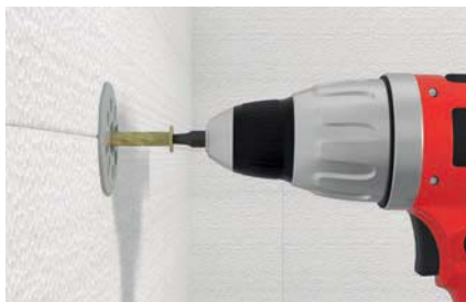
Geschraubte Befestigung von Dämmstoffplatten
