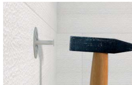
Geschlagener Dübel auf Polystyrol-Hartschaumplatte
